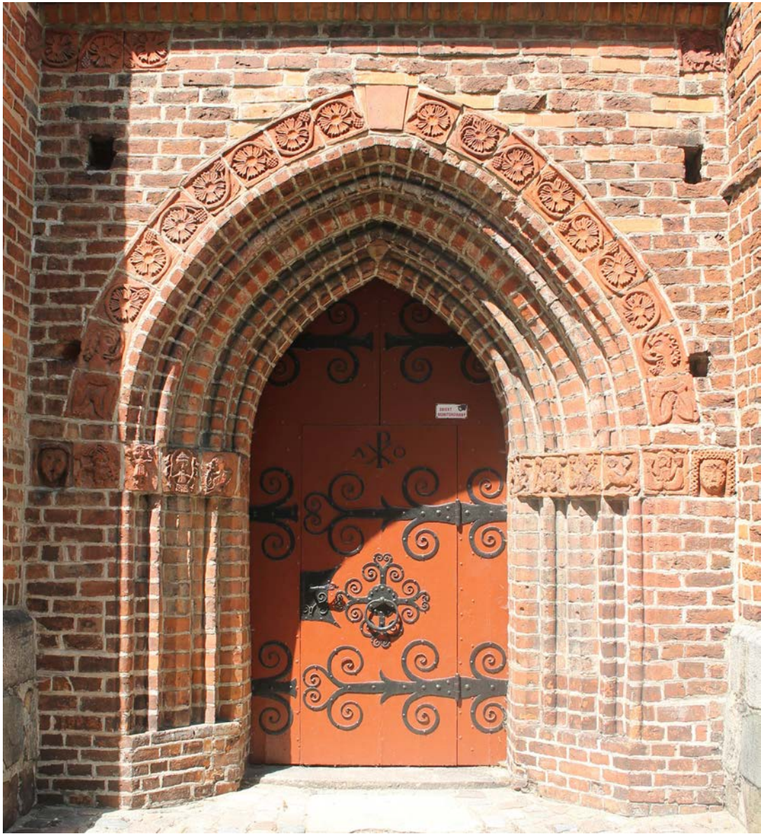
Portal południowy drawskiego kościoła (fot. Tomasz Choroba)
