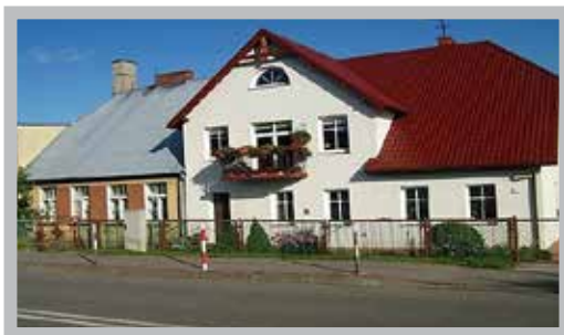
Fot. 4. Budynek, w którym od 1 września 1945 r. mieściła się Szkoła Podstawowa w Ostrowicach. Stan na 2009 r. Fot. Marcin Kuchto
